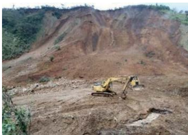
Figura 3. Deslizamiento de tierra km13
