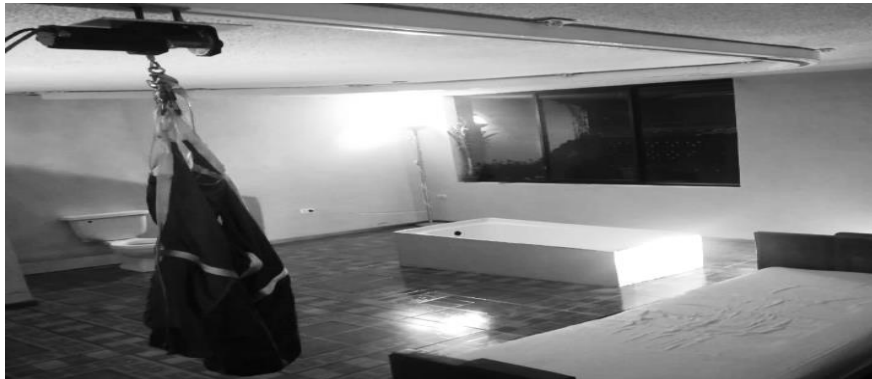
Figura 3. Recorrido en la viga UPN C 80
